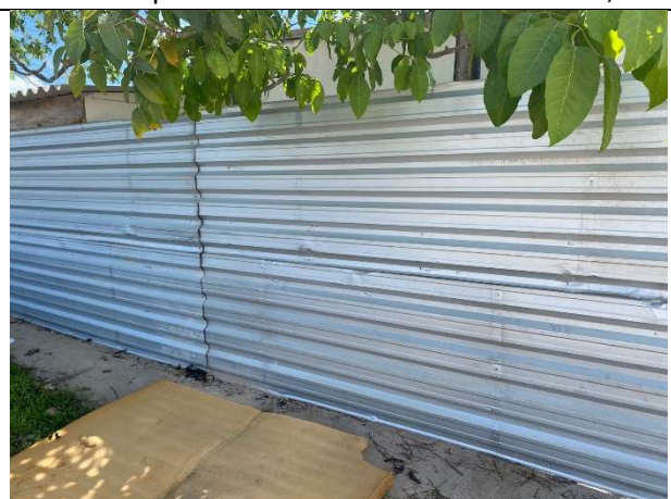
FOTO 4: Tapume com telha metálica instalado;
