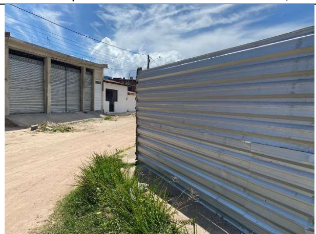
FOTO 6: Tapume com telha metálica instalado;
