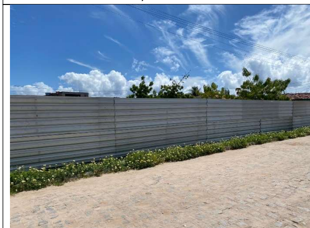
FOTO 3: Tapume com telha metálica instalado;
