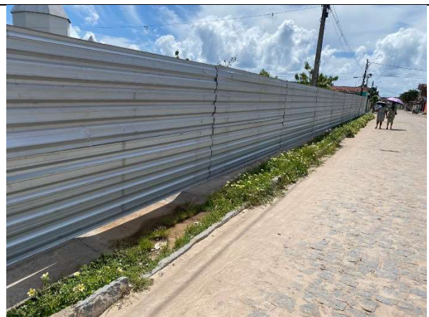
FOTO 2: Tapume com telha metálica instalado;
