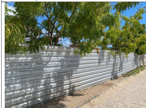
FOTO 5: Tapume com telha metálica instalado;
