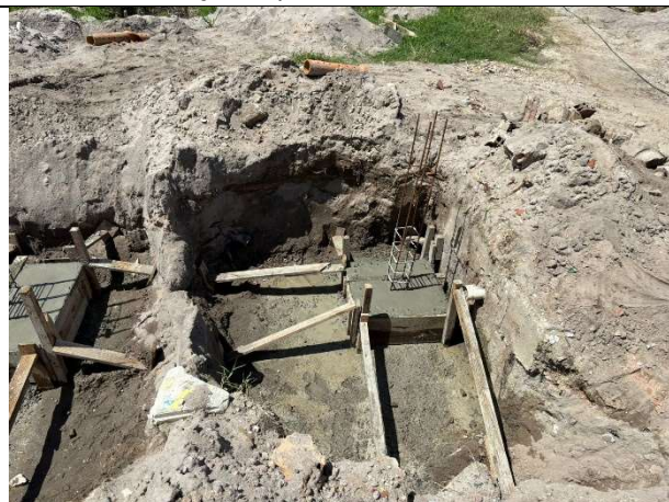
FOTO 11: Sapata concretada;
