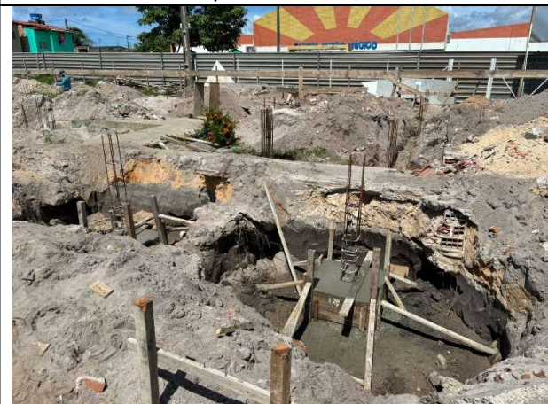
FOTO 17: Sapata concretada;
