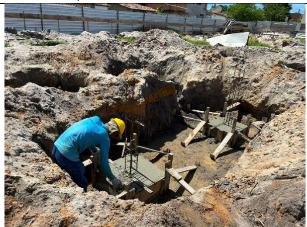
FOTO 16: Sapata concretada;
