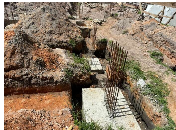
FOTO 13: Sapata concretada;
