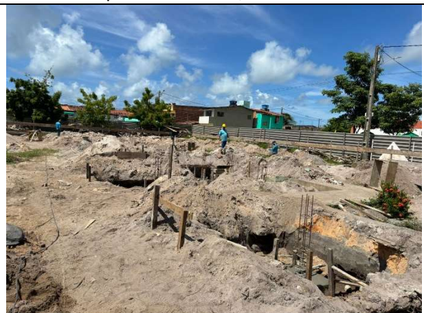
FOTO 18: Sapata concretada;
