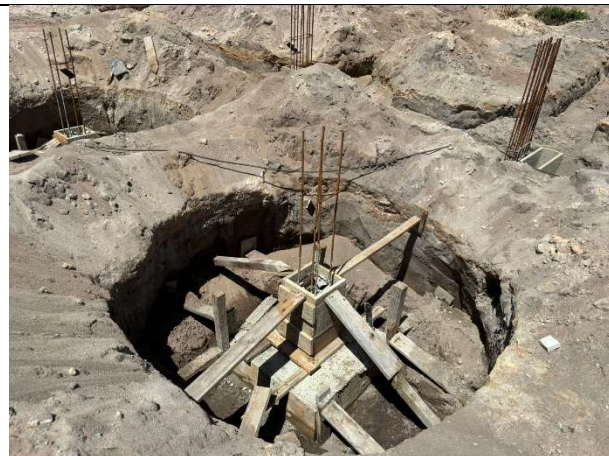
FOTO 10: Pescoço de pilar a ser concretado;
