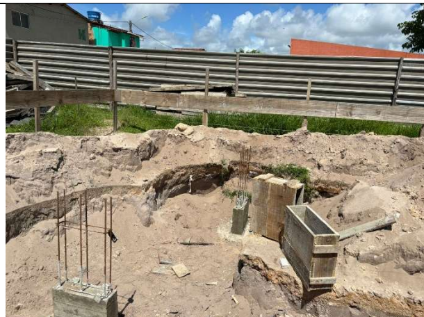
FOTO 9: Pescoço do pilar executado;
