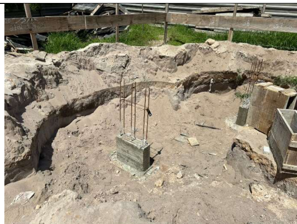
FOTO 8: Pescoço do pilar executado;
