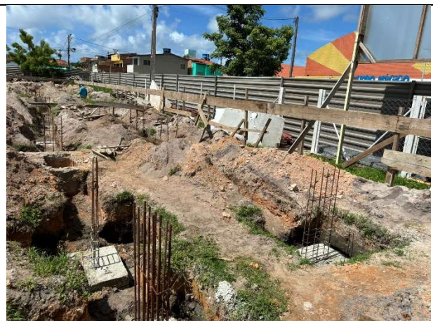
FOTO 14: Sapata concretada;
